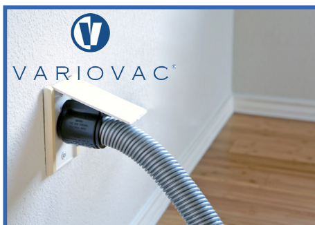
INSTALACJA POD ODKURZACZ CENTRALNY
